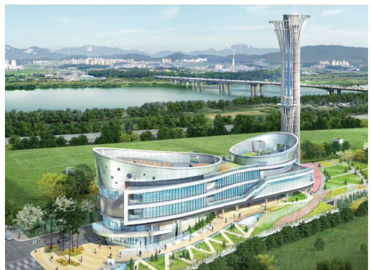
▶강동구 자원순환센터 건립사업 - 복합공정(음식물+음폐수Bio+재활용), 신기술 KABS 적용
